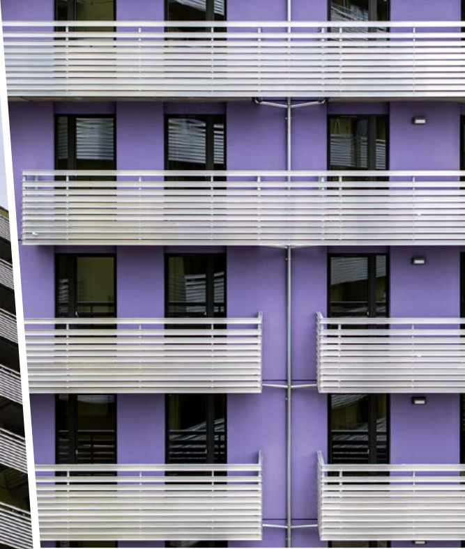
Um die Ecke gedacht: Die Balkonbrüstungen aus Aluminium biegen und wickeln sich dramatisch um die beiden Wohntürme.
