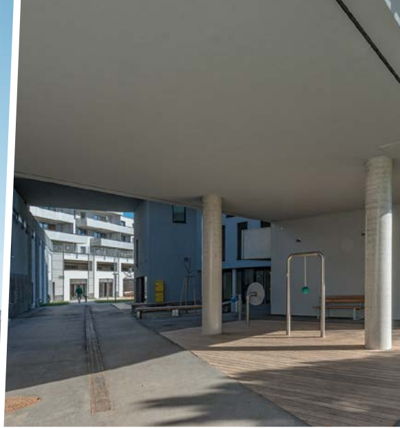
Eine Allee aus Säulen und Nussbäumen: Um die Durchsicht zu maximieren, wurde ein Teil des Hauses auf Stützen gestellt.
