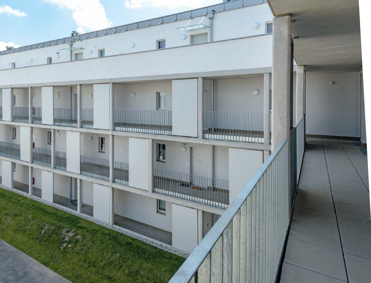
Schützender Schirm: Aus Gründen der Privatheit wurden die Laubengänge im Bereich der Wohnungseingänge mit blickdichten Platten verkleidet.
