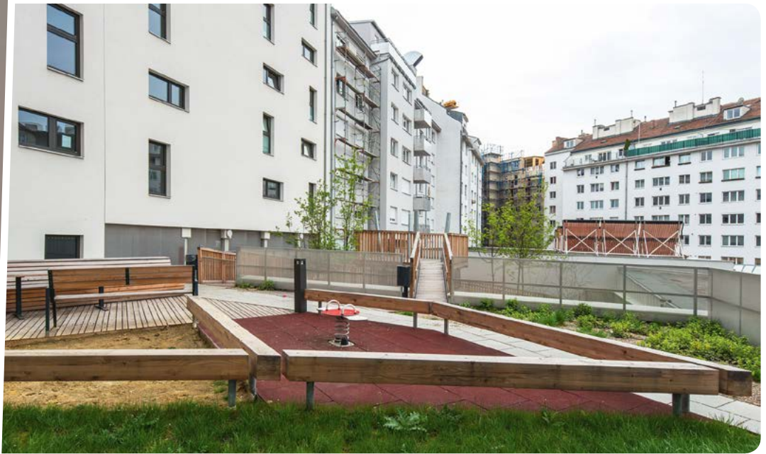
Vom Erdgeschoß führt eine geschwungene Holzwendelrampe in den ersten Stock hinauf. Hier befinden sich der Kinderspielplatz sowie ein großer Fahrradabstellraum.
